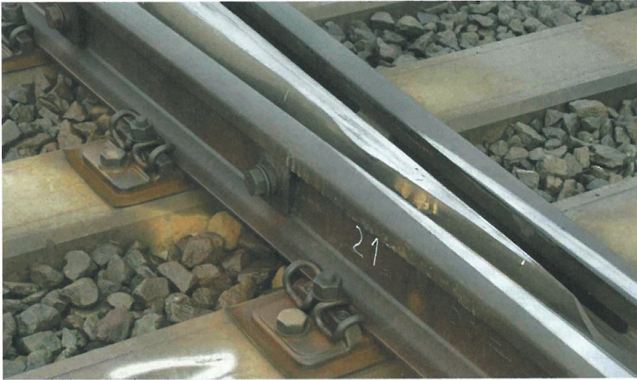
Abb. 1: Plastische Deformation der Herzstückspitze im Bereich des Radüberlaufs
