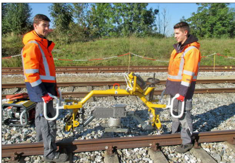
Afb. 35: De machine op de rails plaatsen
