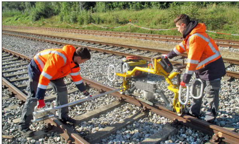
Afb. 37: De cantilever monteren
