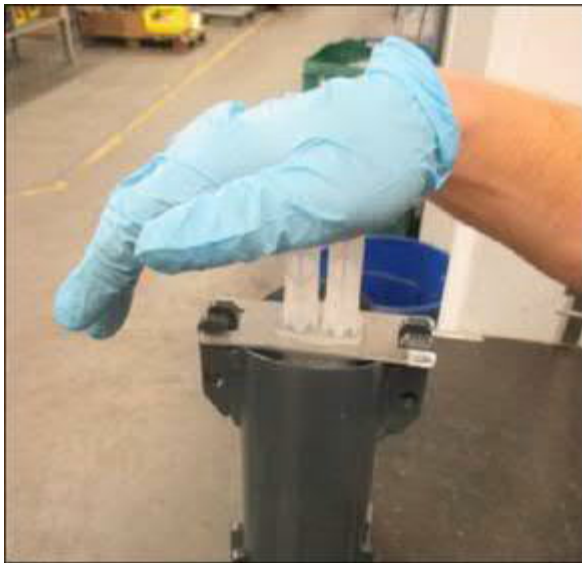
Afb. 39: Epoxyhars in het stopwerktuig inspuiten
